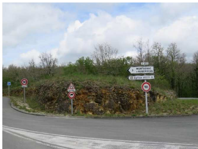
Signalisation à l'insertion sur la VC 301 au niveau du carrefour avec la RD 68
